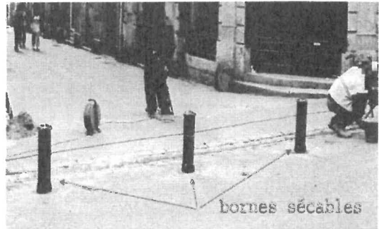
Bornes sécables par un homme sur poussée
